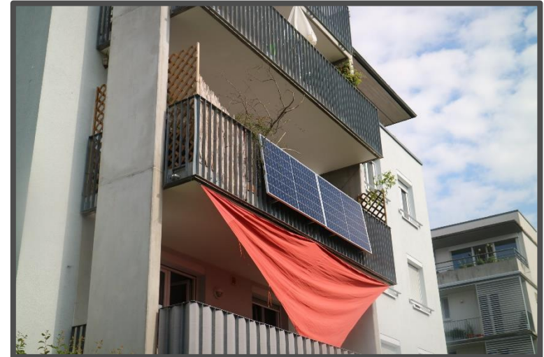
Balkon-PV-Anlage in Freiburg-Rieselfeld
