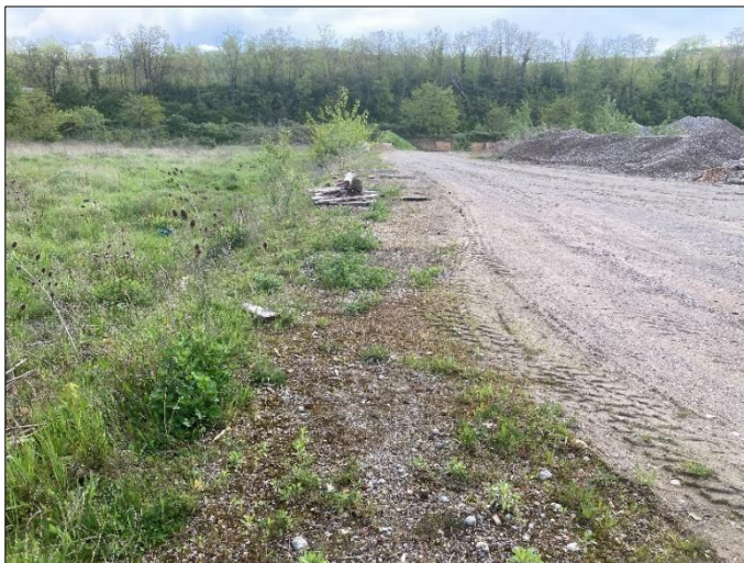
Abb.3: Abbruchkante am nördlichen Ende des Geltungsbereichs.
